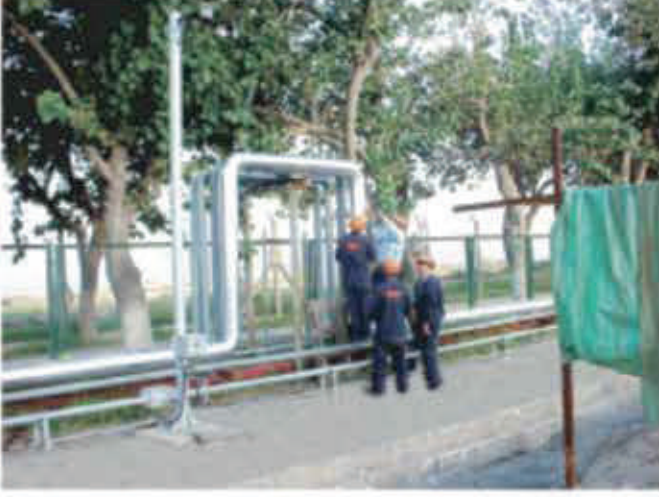
Akaryakıt boru hatlarının izolasyon işleri
